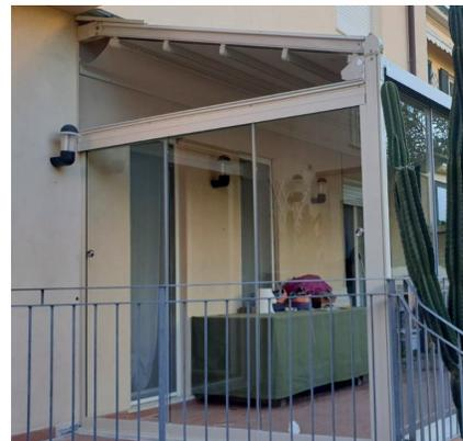
Solitamente viene installato un traverso orizzontale tra la parete il piantone frontale e la parte obliqua superiore viene tamponata con tessuti in cristal, opachi o lastre leggere in policarbonato o in acrilico.
